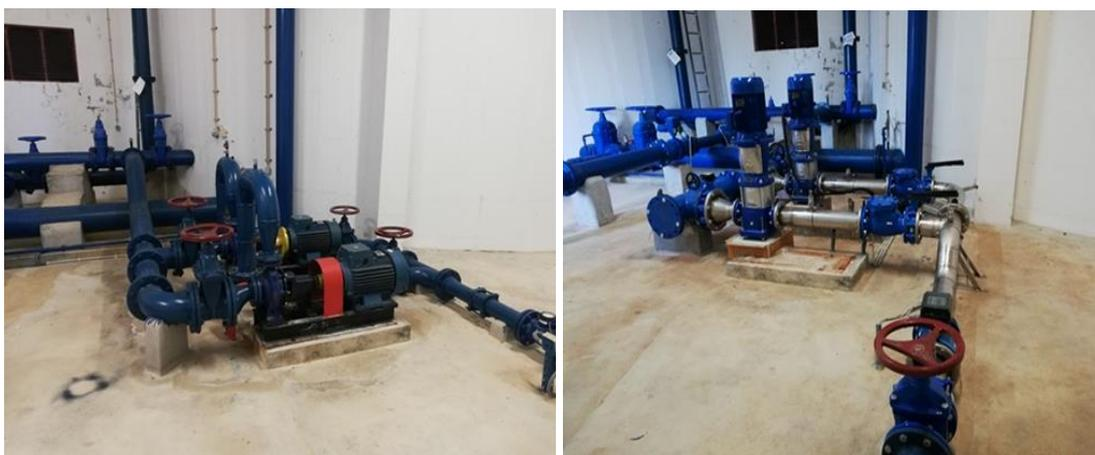
Na captação JK19 das Portelas da Reixida, foi substituído o grupo de elevação bem como a tubagem de bombagem do furo. Nesta captação aumentamos a capacidade de captar água de 90 m<sup>3</sup>/h para 105 m<sup>3</sup>/h. Esta captação fornece 86% da água ao sistema de abastecimento de Cortes.
