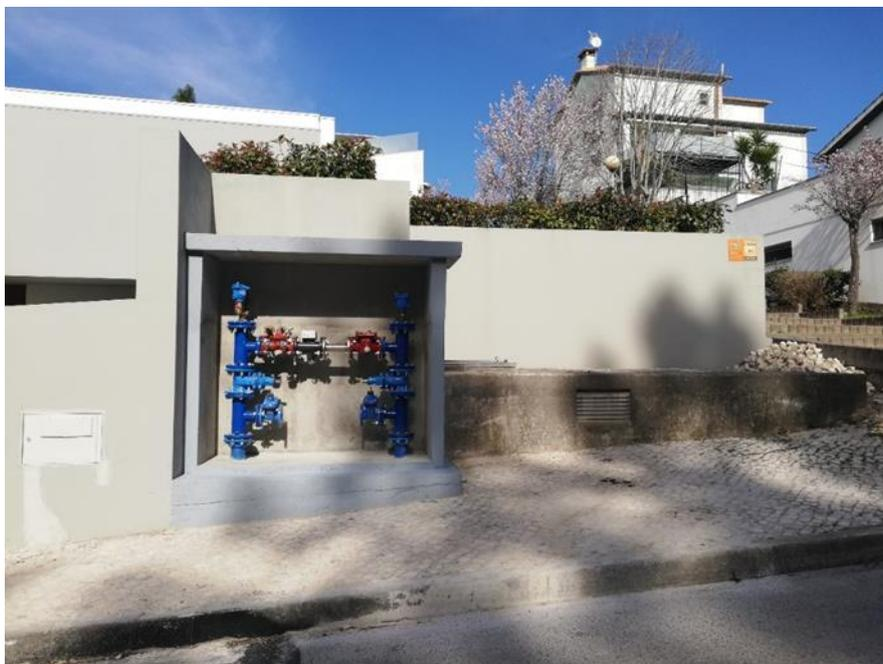
2. Com a construção de uma nova conduta adutora distribuidora a partir do R. Pousos e com a construção da nova ZMC 25 do Vidigal, permitiu a desativação do R. Vidigal. Esta obra permitiu a simplificação do controlo de bombagem da ETA de São Romão e irá permitir poupar energia no futuro. A criação da ZMC permitirá conhecer o abastecimento a esta zona da freguesia dos Pousos.
