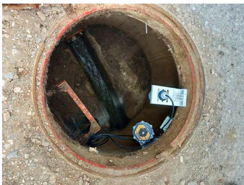
Instalação de medidor de nível de Radar e datalogger – Ponto de entrega do Ulmeiro
