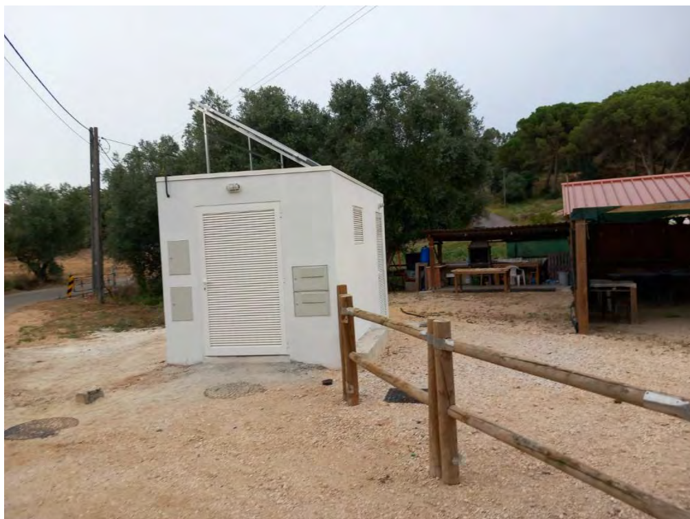
Aspeto da EEAR Freiria
